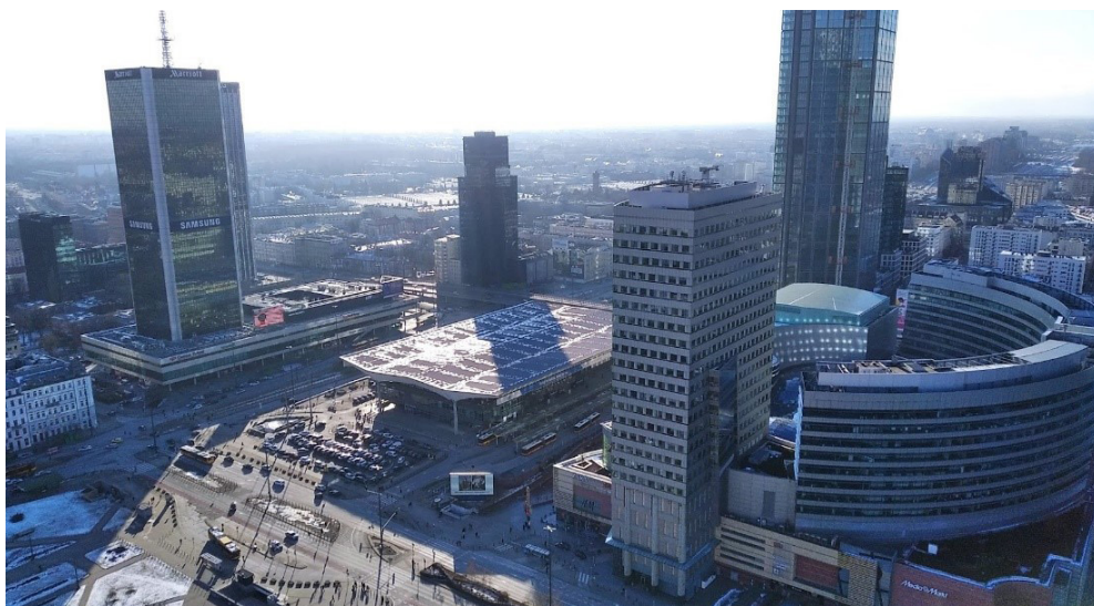
Приклад забудови, за принципом TOD, ст. Варшава-Центральна. Фото: ORESUND
