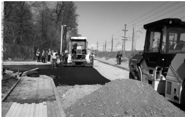
Ремонтні роботи на вулиці Підгірній, м. Ірпінь
