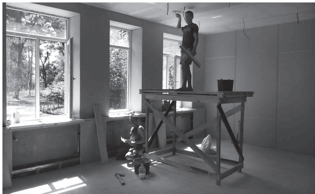
Ремонтні роботи в школі №1
