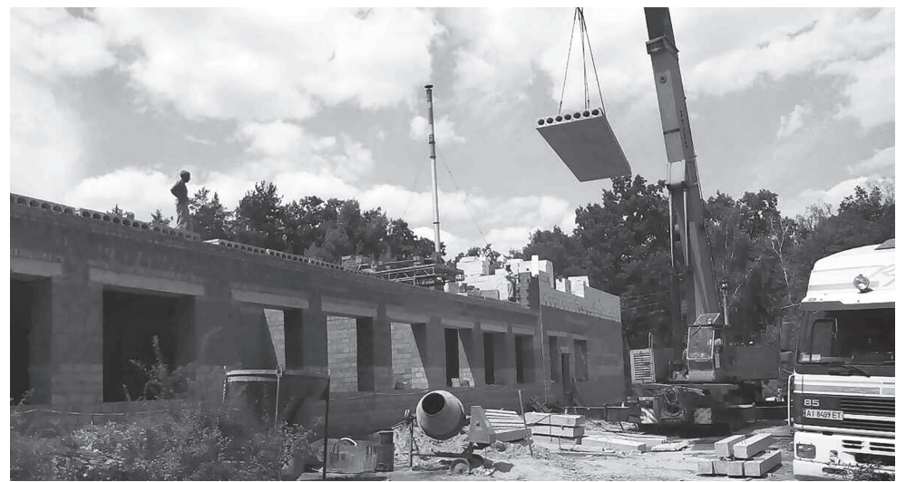
Будівництво прибудови Ірпінської школи №13
