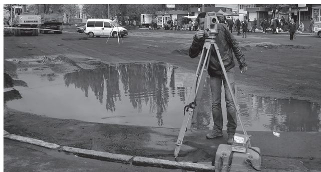
Ремонтні роботи на площі Антонова
