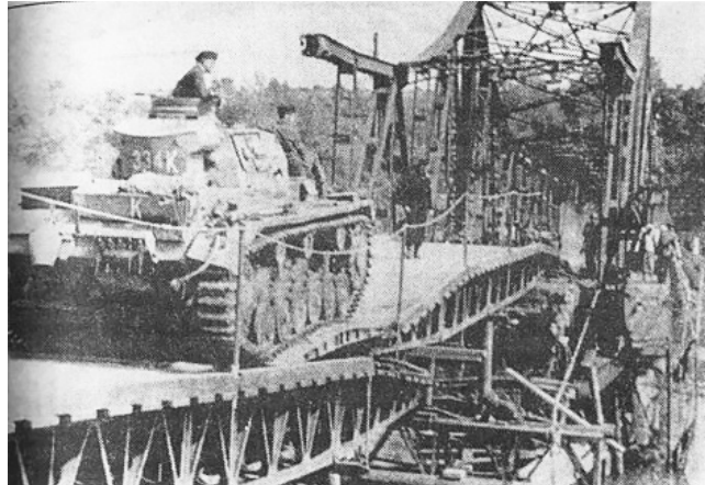
Зруйнований міст через річку Ірпін
